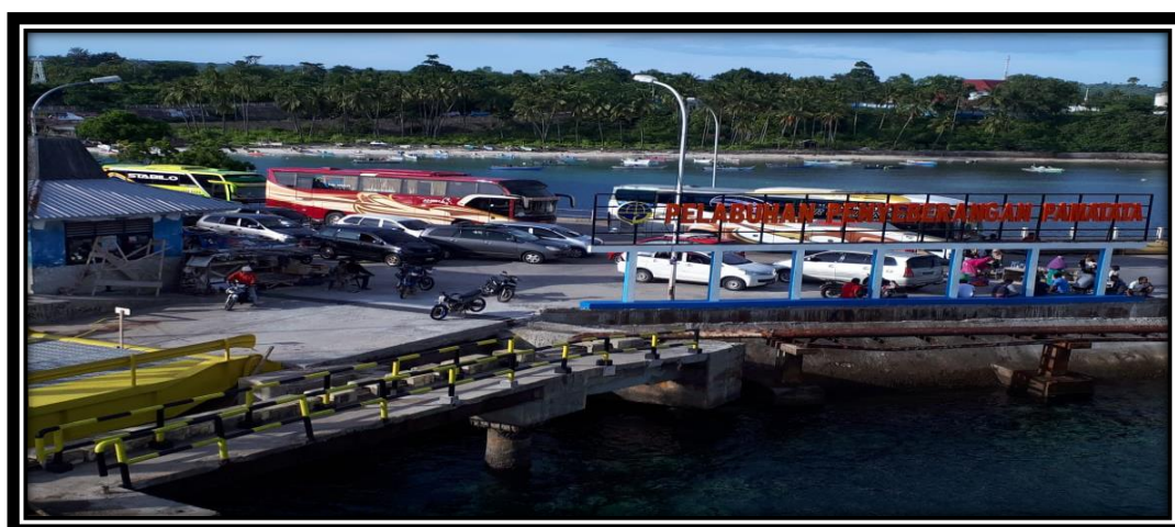
Gambar 2.3 Pelabuhan Penyeberangan Pamatata
