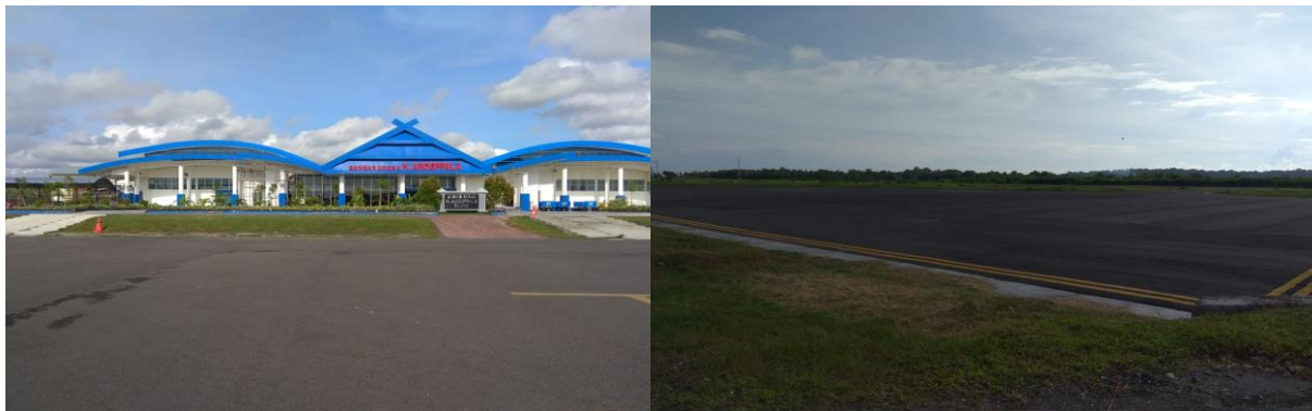
Gambar 2.2 Area Parkir Pesawat ( Apron ) Bandara H. Aroeppala
