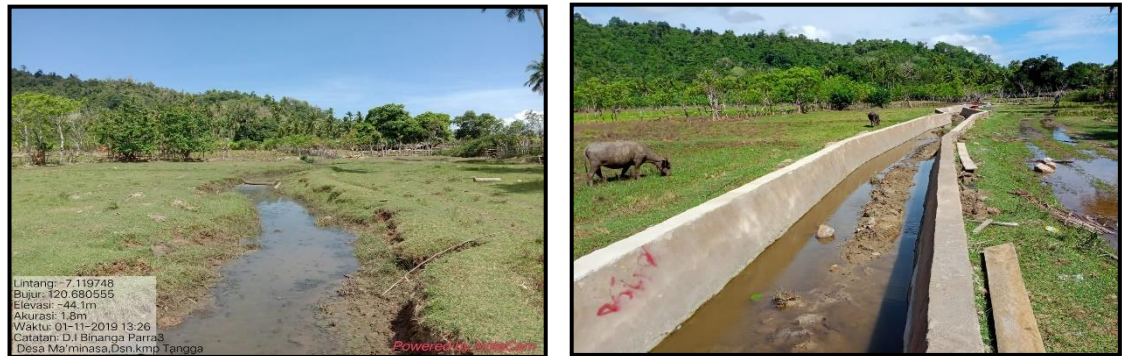
Gambar 2.6: Rehabilitasi /Pemeliharaan Jaringan Irigasi D.I. Binanga Parra 3 (Kecamatan Pasimasunggu)
